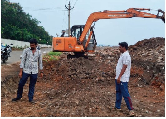
లోని గంగవరం నుంచి పెదగంట్యాడ రహదారి పనులు
